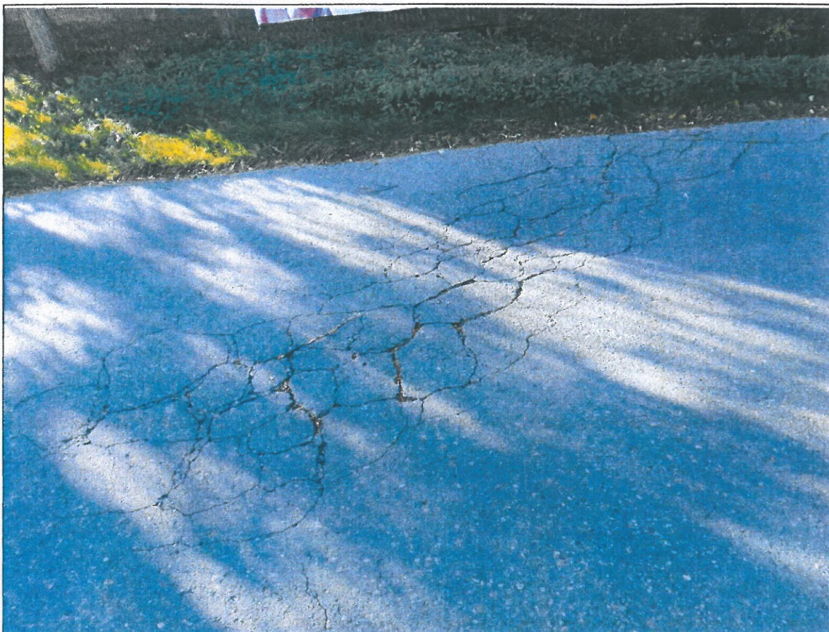
Pęknięcie w nawierzchni drogi (październik 2019)
